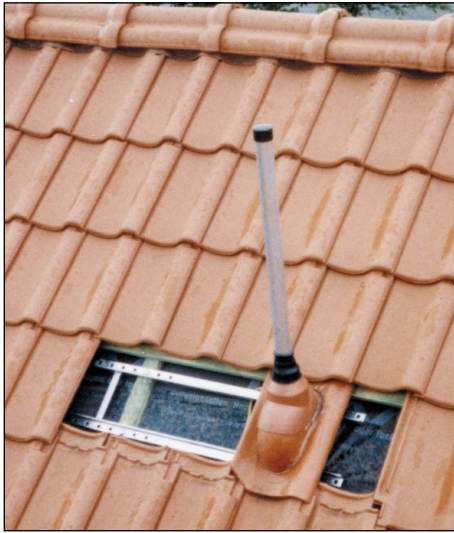
Bild 01: Richten Sie Satfix mit Hilfe der Dachziegel aus.
