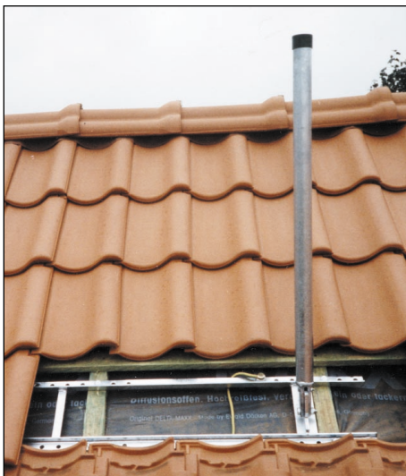
Bild 02: Verschrauben Sie Satfix auf den Sparren und erden Sie die Halterung.
